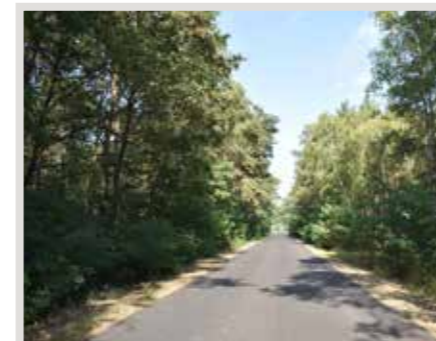
⚡ Droga 5592 - nawierzchnia slurry-seal w Bobrownikach
