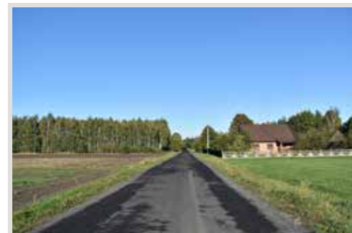
⚡ Droga nr 5589 powierzchniowe utrwalenie w m. Klon
