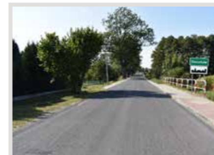
⚡ Dr 5593 - wylot w kier. Plugawic - dywanik asfaltowy na moście oraz powierzchniowe utrwalenie na całości
