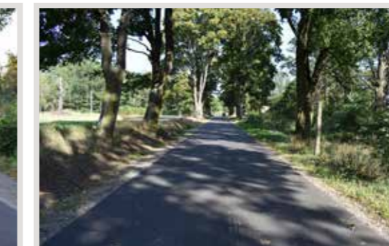
⚡ Dywanik asfaltowy w m. Plugawice
