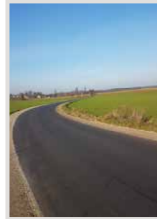
Droga nr 5334 Bledzianów-Niedźwiedź
