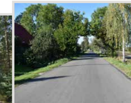
⚡ Droga nr 5582 - dywanik asfaltowy Kottów-Kaliszkowice Ołobockie
