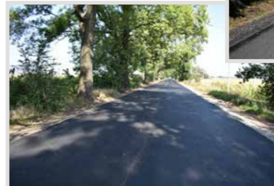
Droga nr 5599 Doruchów - Kępno odc.1 km
